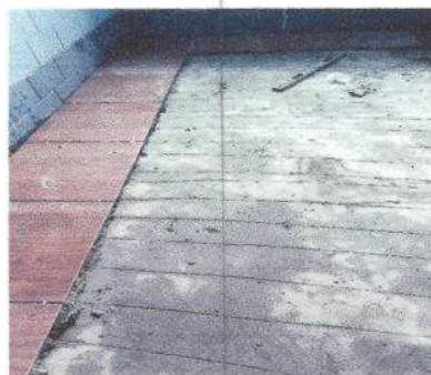
Foto 4: Sustrucción de piso de cemento líquido por cerámico.
