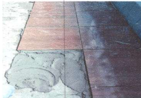
Foto 2: Sustrucción de piso de cemento líquido por cerámico.
