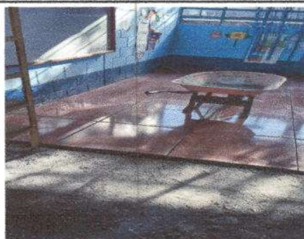
Foto 6: Sustrucción de piso de cemento líquido por cerámico.
