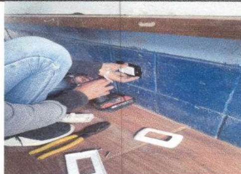
Foto 4: Sustitución de tomacorrientes dobles
