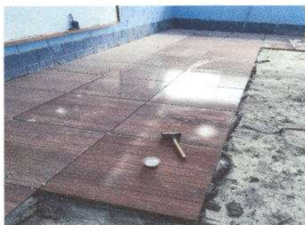
Foto 1: Sustrucción de piso de cemento líquido por cerámico.
