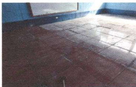
Foto 5: Sustrucción de piso de cemento líquido por cerámico.
