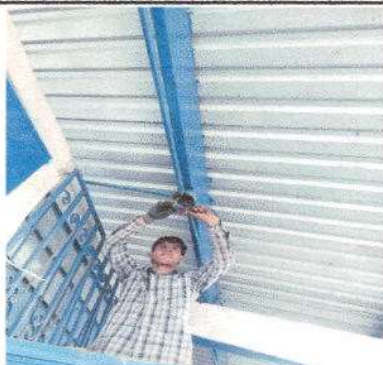
Foto1: Sustitución de focos ahorradores
