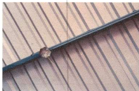
Foto 2: Sustitución de plafoneras
