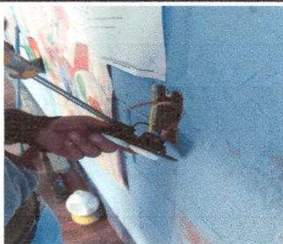
Foto 3: Sustitución de interruptores dobles
