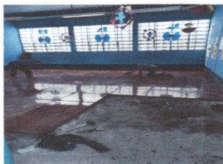
Foto 3: Sustrucción de piso de cemento líquido por cerámico.
