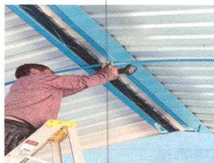
Foto 6: Sustitución de ducto eléctrico
